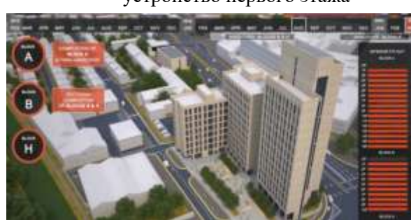
е) заключительный период подготовка к сдаче в эксплуатацию
