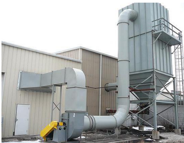
Рисунок 3 - Индустриальный рукавный фильтр.
