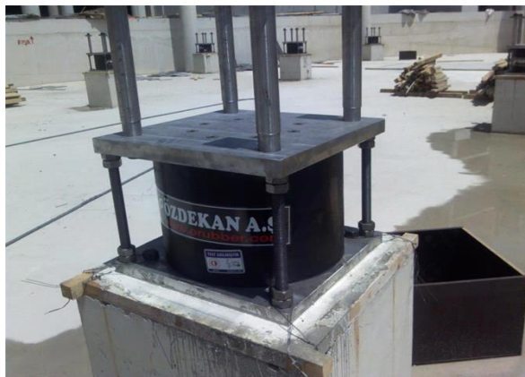
Рисунок 2 - Устройство сейсмоизолятора
